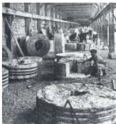
Le rhabillage des meules de notre moulin par Peter Thomaes et son ouvrier, à gauche avec une boucharde pneumatique et à droite avec un piochon.
