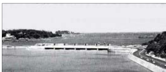
Un moulin à marée moderne: l'usine marémotrice de la Rance, qui n'écrase rien mais produit de l'électricité à l'aide de turbine actionnées par la force des marées.
