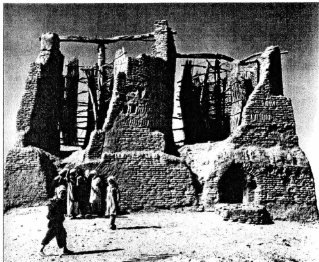
Moulin à axe vertical du Seistan - Photo J. Bourgeois
