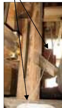
Mécanisme par levier actionnant le tirant (à l'intérieur de l'arbre couché) de manœuvre du système de commande de l'ouverture ou fermeture des volets sur les ailes
