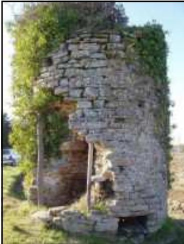
L'état de la tour en 2006, ci-dessus, et en juillet 2012 ci-dessous
