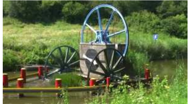
En aval le câble fait un retour sur trois grandes roues.
