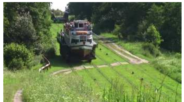
Deux chariots circulent sur deux voies ferrées sur la dénivellation entre deux portions de canal en eau. Un câble tire l'un en montée et retient l'autre en descente.
