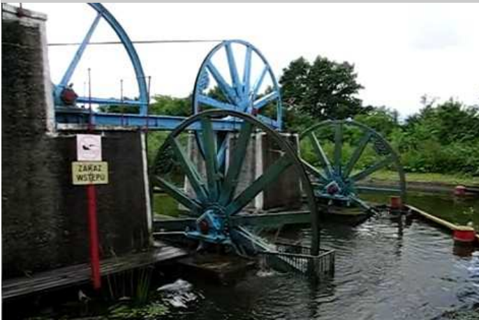
En amont le câble est guidé par quatre grandes roues.
