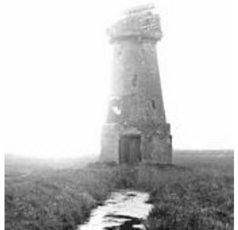
Moulin de l'Hostine ou moulin Regost de LOOBERGHE (Nord). La base de la tour est en maçonnerie et la partie supérieure est une ossature en bois recouverte d'essences. (Il ne subsiste de nos jours que la base en maçonnerie)
