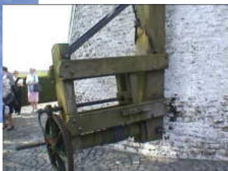
La queue du moulin ou gouvernail, et le treuil qui servait à orienter la toiture et les ailes face au vent
