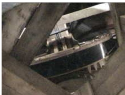
La queue du moulin ou gouvernail, et le treuil qui servait à orienter la toiture et les ailes face au vent
