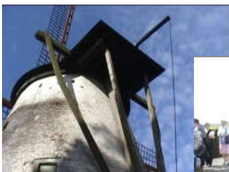
La queue du moulin ou gouvernail, et le treuil qui servait à orienter la toiture et les ailes face au vent
