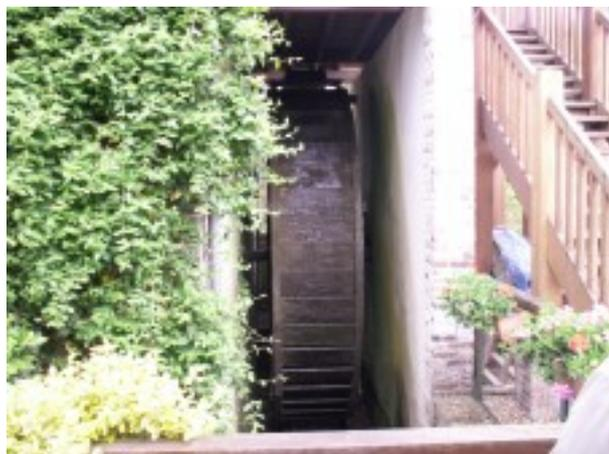
Le moulin de Saint Ouen de Pontcheuil possède une roue à augets de 4.50 m de diamètre, avec 48 augets. Elle est couverte. « Une tête d'eau » alimente la roue « par dessus ».
